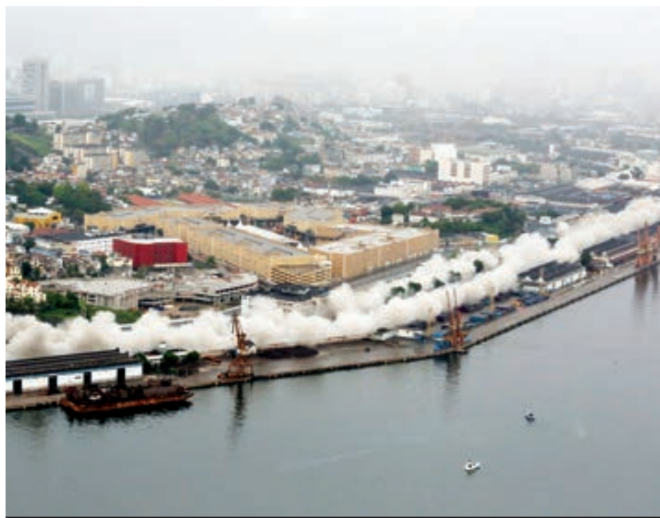
Engenheiros utilizaram 1,2 tonelada de explosivos para realizar implosão | DIVULGAÇÃO PREFEITURA DO RIO DE JANEIRO
